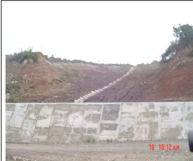
Aspecto general del talud central. Se aprecia el muro en concreto reforzado. La carencia de cobertura vegetal incidió en la generación de surcos de escorrentía.
