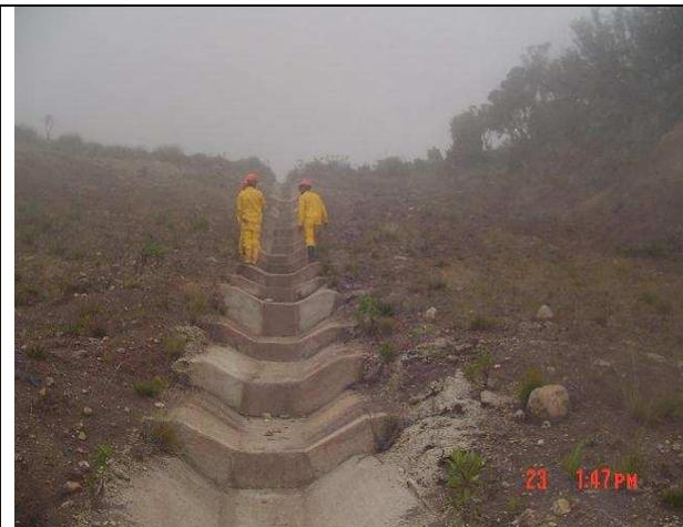
Detalle del descole ubicado en el talud central. El sector aledaño completamente desprotegido aledaño completamente desprotegido.
